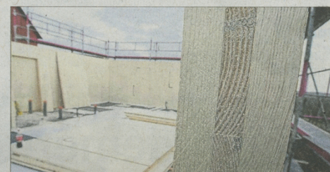
Le bois, à la fois structure et finition. « L'idée est d'utiliser des matériaux les plus bruts possibles ».
